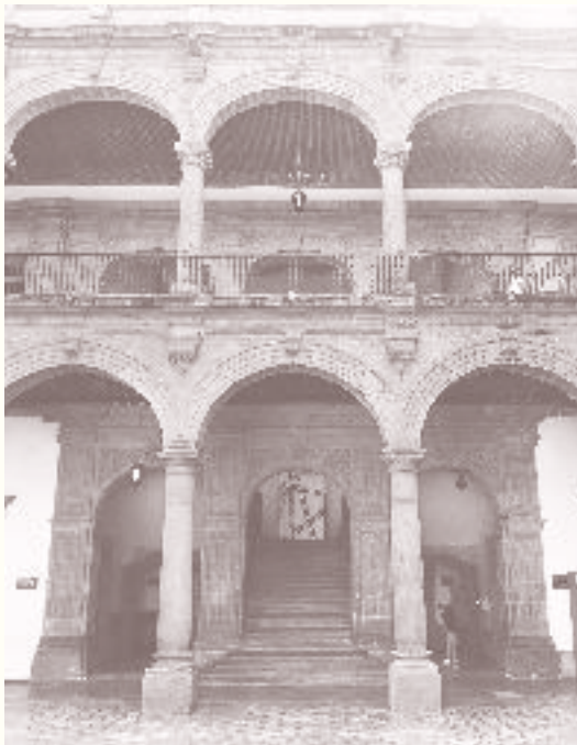
Arcos de medio punto en planta baja y carpanel en planta alta. Patio central del Tribunal de la Inquisición. Fotografía: Xavier Cortés Rocha, 2019.
