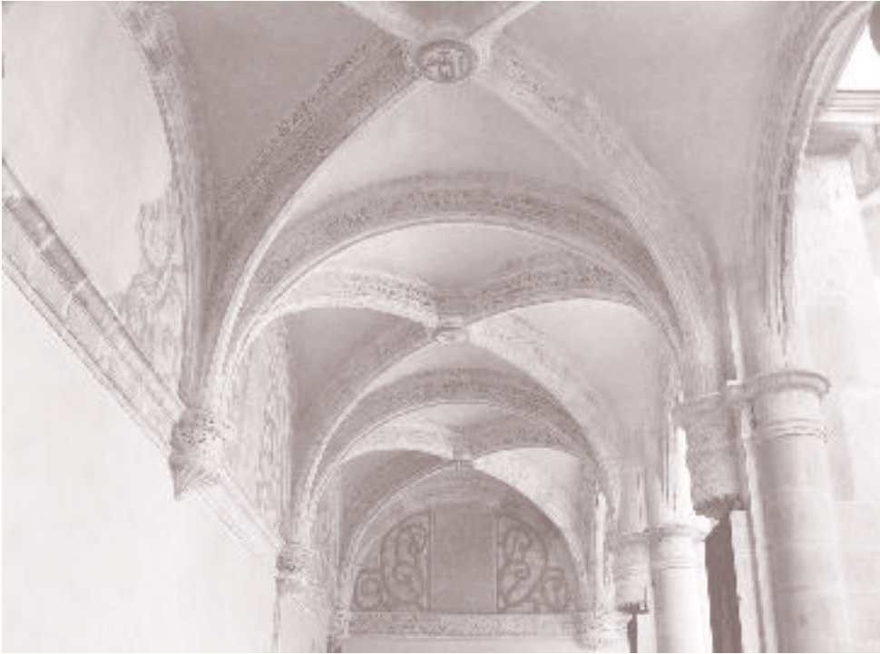
Bóveda del convento de Santo Domingo, Oaxaca. Fotografía: Xavier Cortés Rocha, 2009.
